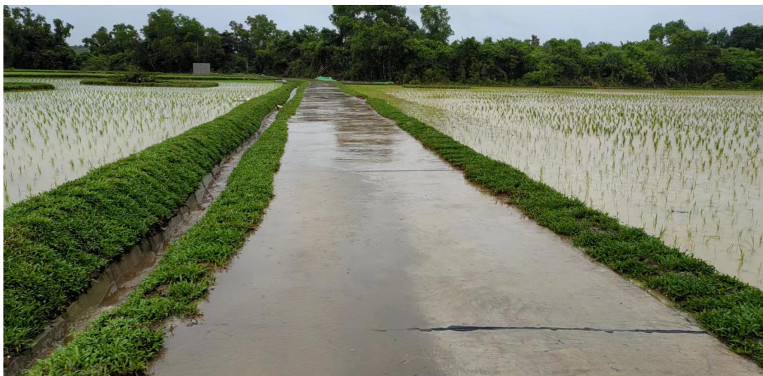
生产路施工后
