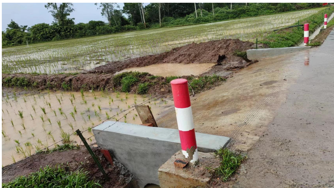
下田坡道施工后
