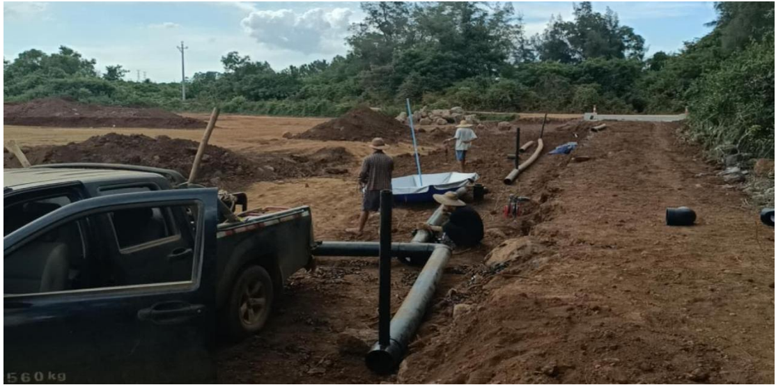
灌溉管道施工中
