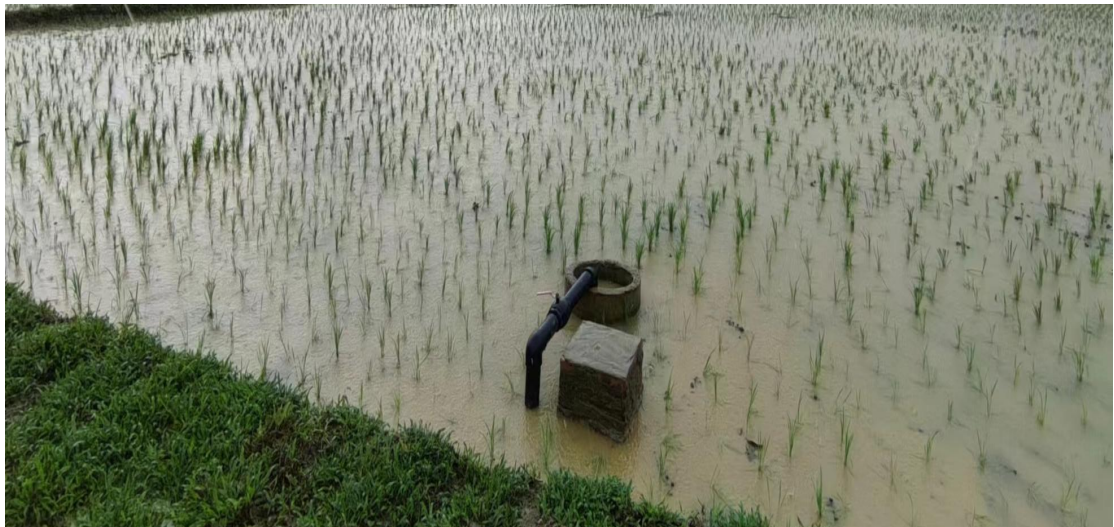
灌溉管道施工后
