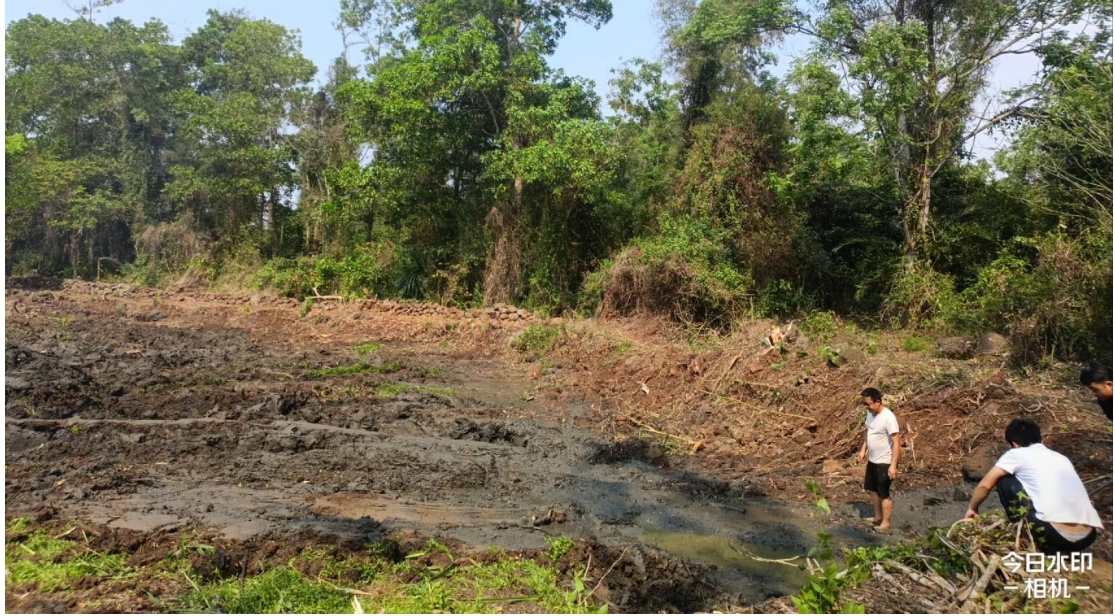
2号地块施工前
