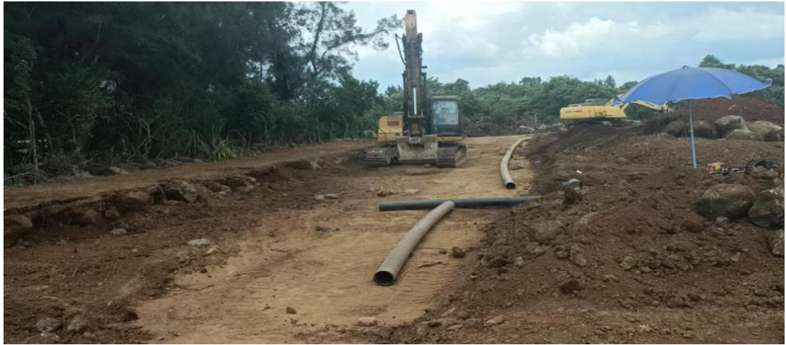
灌溉管道施工前
