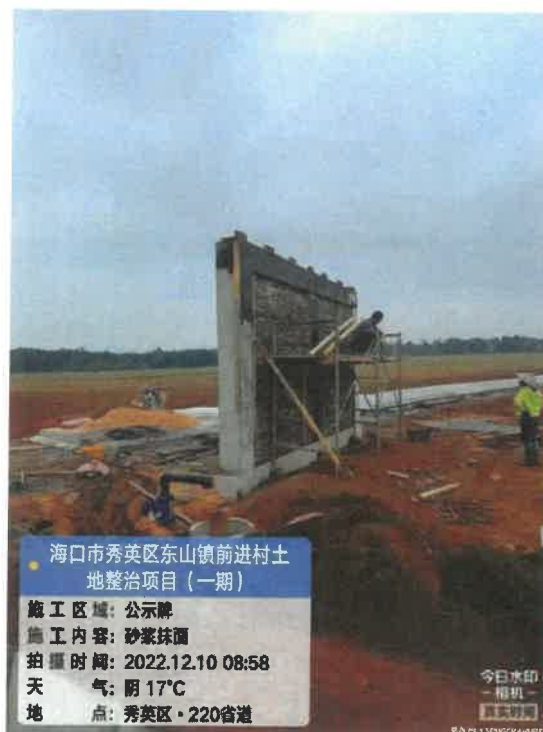
公示牌砖墙抹灰
