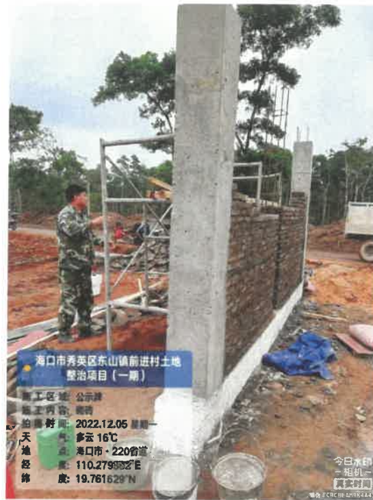
公示牌砌砖墙
