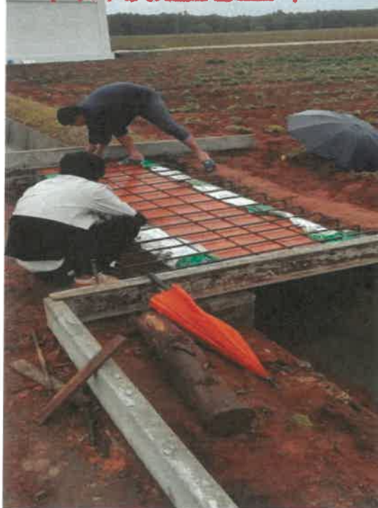
下田坡道施工中
