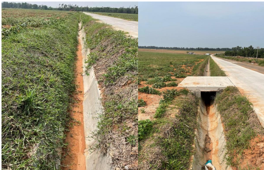
3、排水设施照片
