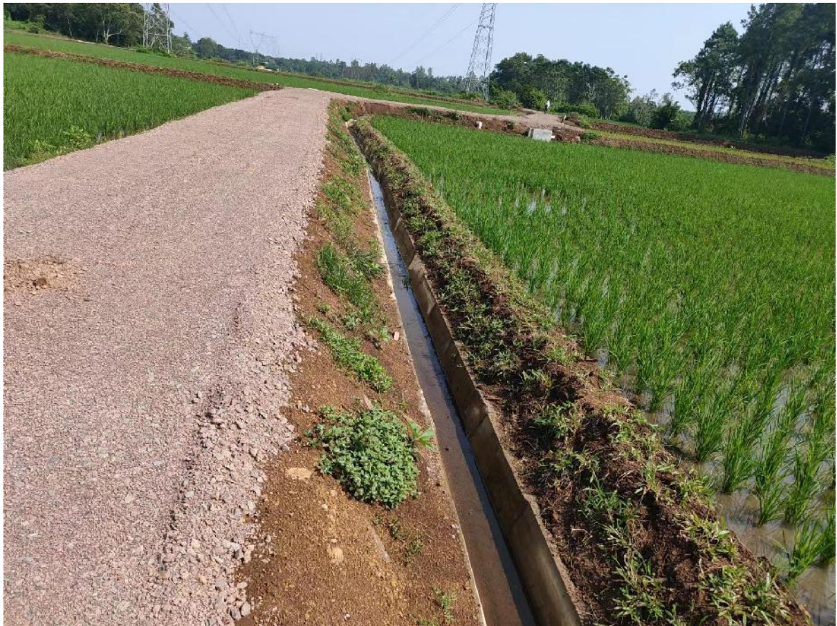
图 3 海口市龙华区龙泉镇翰香村委会土地整治项目实地照片
