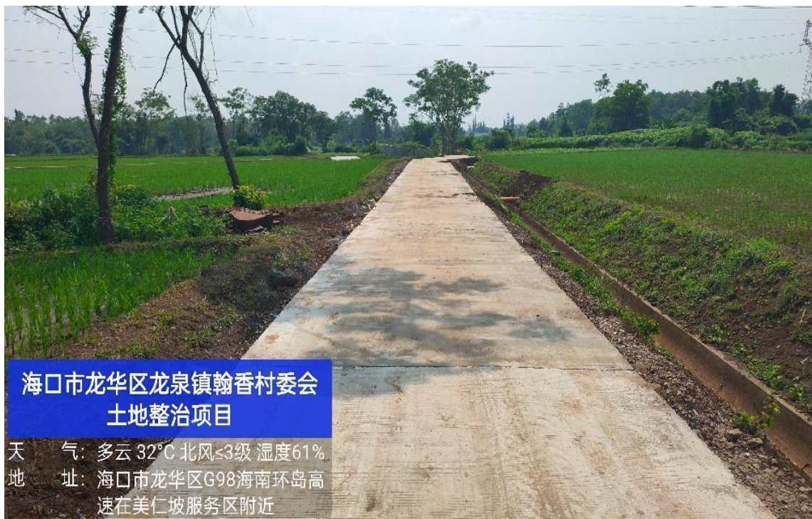
图 6 海口市龙华区龙泉镇翰香村委会土地整治项目实地照片
